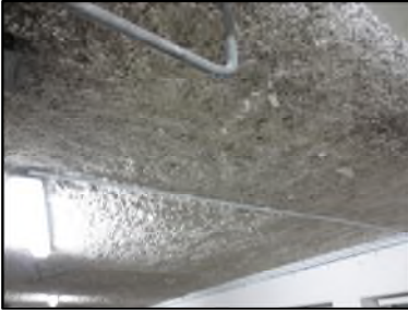
Photo N° 585 ECH-N°1 FLOCAGE -- Parking Plafonds Blanc cotonneux
